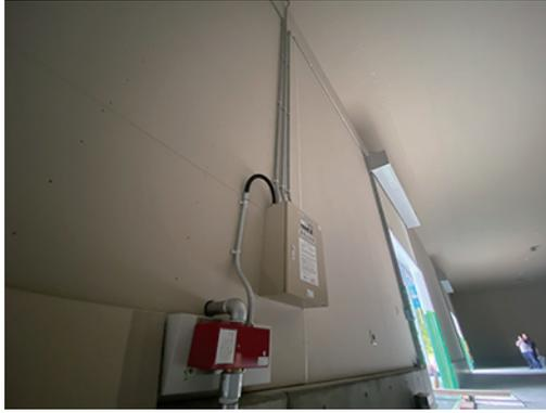
万が一の火災発生で停電が起きても、火災感知後にシャッターが自動で開き、消火活動の開口部を作る。
